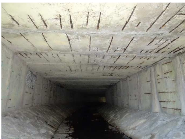
Podhled NK od návodní strany mostu.
