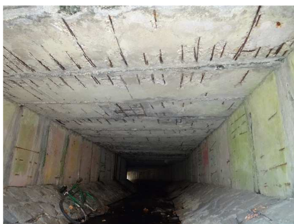
Pohled do mostního otvoru z povodní strany mostu.
