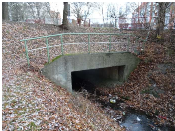
Pohled na vtokovou (návodní) stranu mostu.
