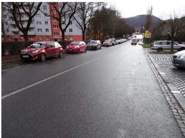
Pohled na šířkové uspořádání komunikace nad mostním objektem.
