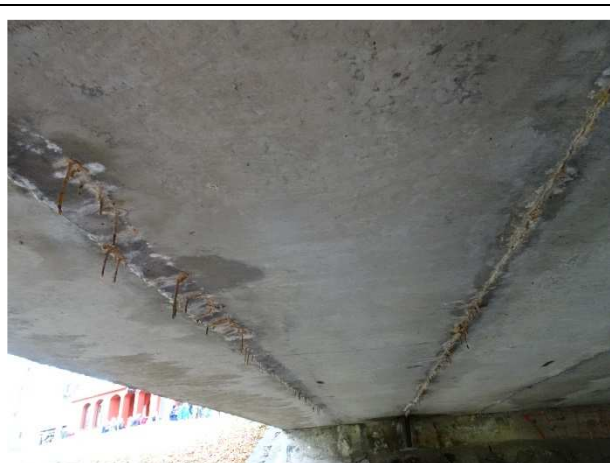
Povodní strana pohledu NK ve směru k Op1.
