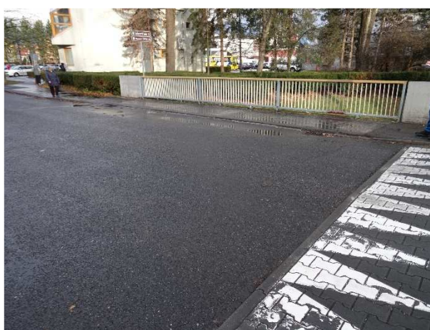
Pravá strana mostu.
