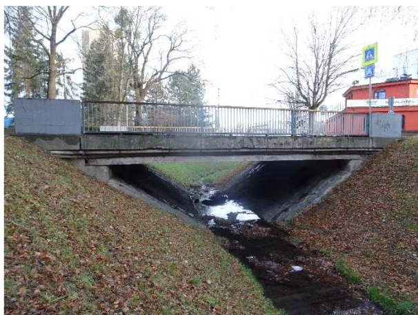
Návodní strana mostu.
