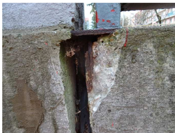
Překrytí dilatační spáry v pravé římse nad Op1.
