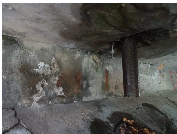
Vyústění pravého odvodňovače pod spodním povrchem NK.
