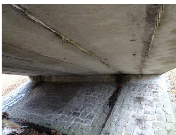
Pohled na levobřežní opěru (Op2).
