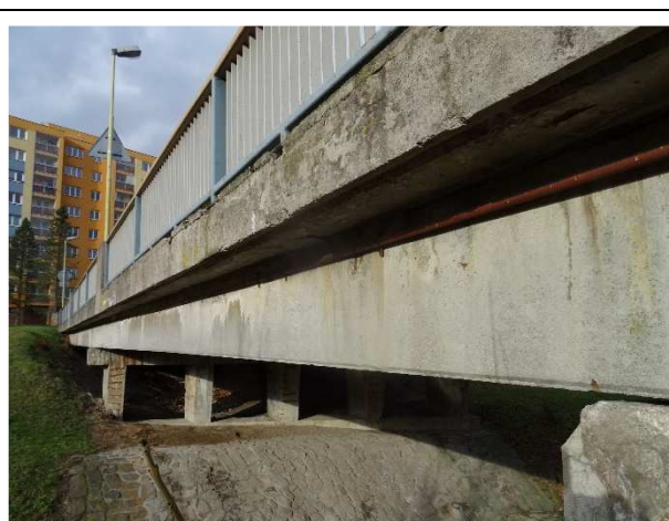
Pravá fasádní strana NK a římsy v pohledu od Op3.
