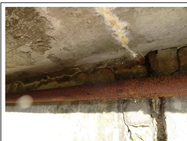
Podhled pravé římsy v místě nad P2.
