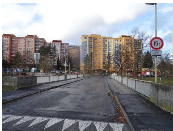
Pohled na most ve směru od pravého břehu překonávané vodoteče k levému.
