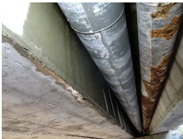
Levé krajní prefa nosníky NK v 1. poli. Stěna 2. nosníku zleva je celá smáčená.
