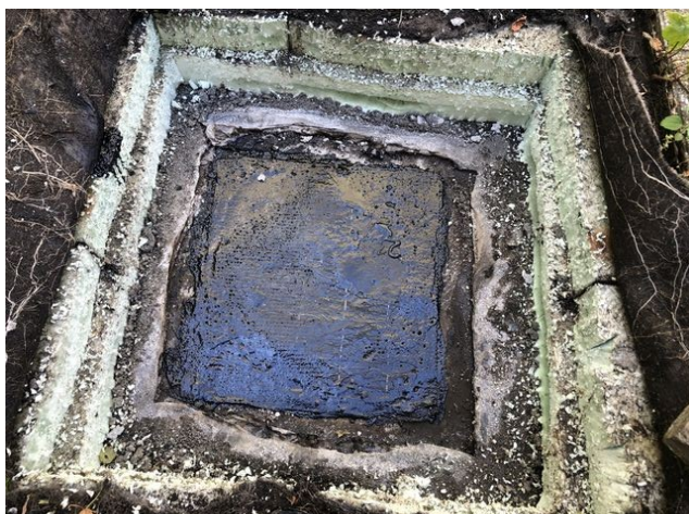
obr. /4/ Pohled na zapravení hydroizolační vrstvy
