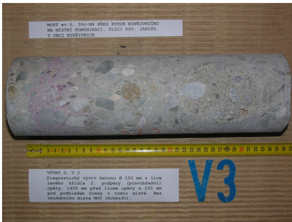
Obr. F86-302 VÝVRT č. V3. Diagnostický vývrt betonu Ø 100 mm z líce levého křídla 2. podpěry (pravobřežní) opěry, 1400 mm před lícem opěry a 100 mm pod podhledem římsy v tomto místě. Bez zkušebního místa NDT (Schmidt).
