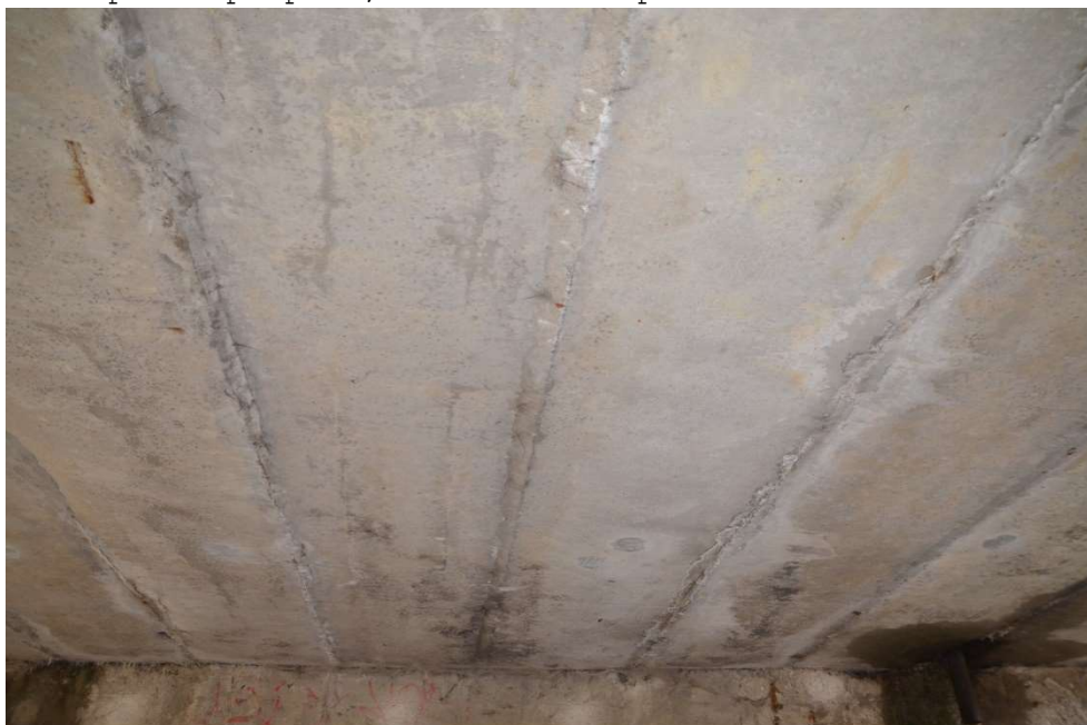
Obr.F86-22 Podhled prostřední části první poloviny NK. Pohled od druhé podpěry, pravobřežní opěry proti směru staničení a vzhůru,
