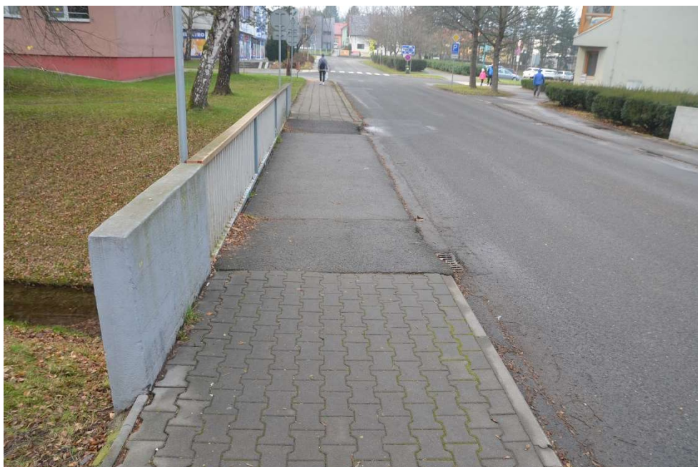
Obr.F86-36 Průhled pravým chodníkem a pravou částí vozovky. Pohled proti směru staničení a dolů,
