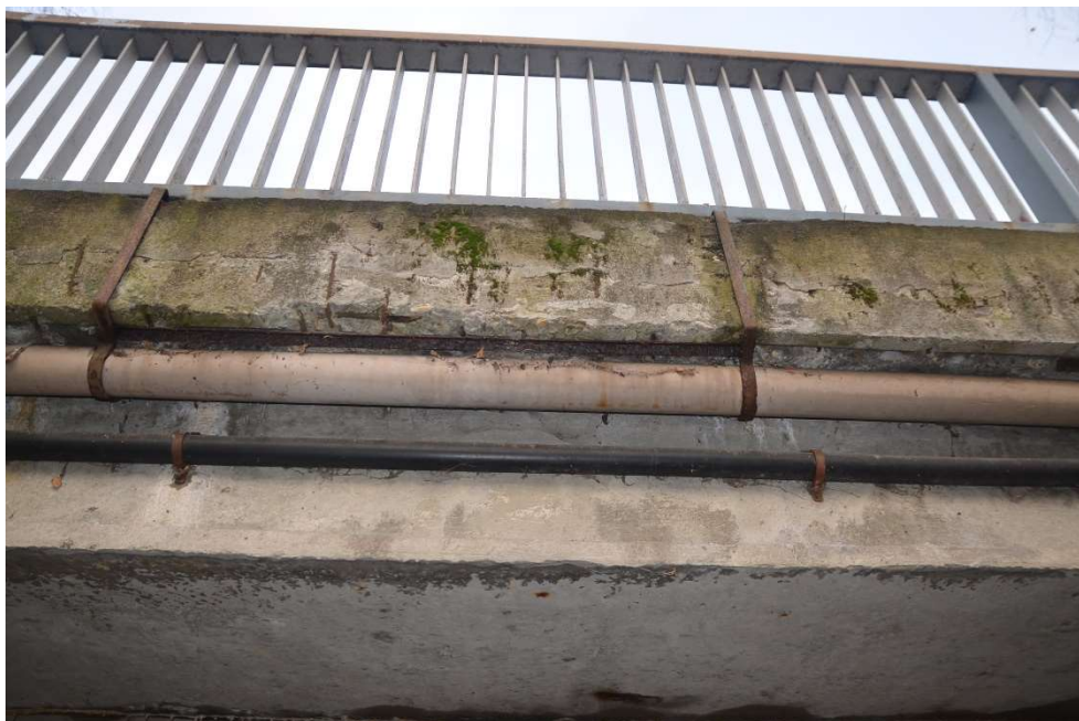
Obr.F86-19 Pravá (návodní) fasáda přibližně ve 2. třetině rozpětí mostu. Pohled zprava doleva, po vodě a vzhůru,
