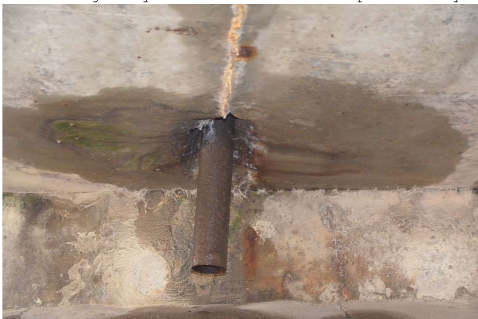
Obr.F86-39 Detail odvodňovací trubky v podélné spáře mezi nosníkem č.9 a č.10 při první podpěře, levobřežní opěře. Pohled proti směru staničení a vzhůru,
