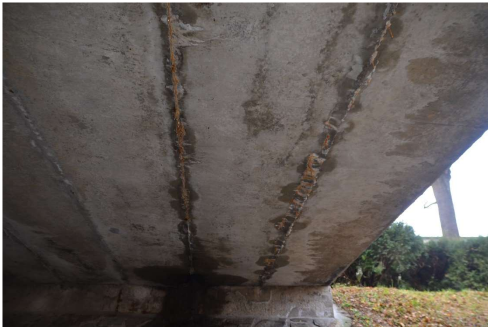
Obr.F86-21 Podhled levé části první poloviny NK (na obr. zcela vpravo nosník č. 1). Pohled od druhé podpěry, pravobřežní opěry proti směru staničení a vzhůru,
