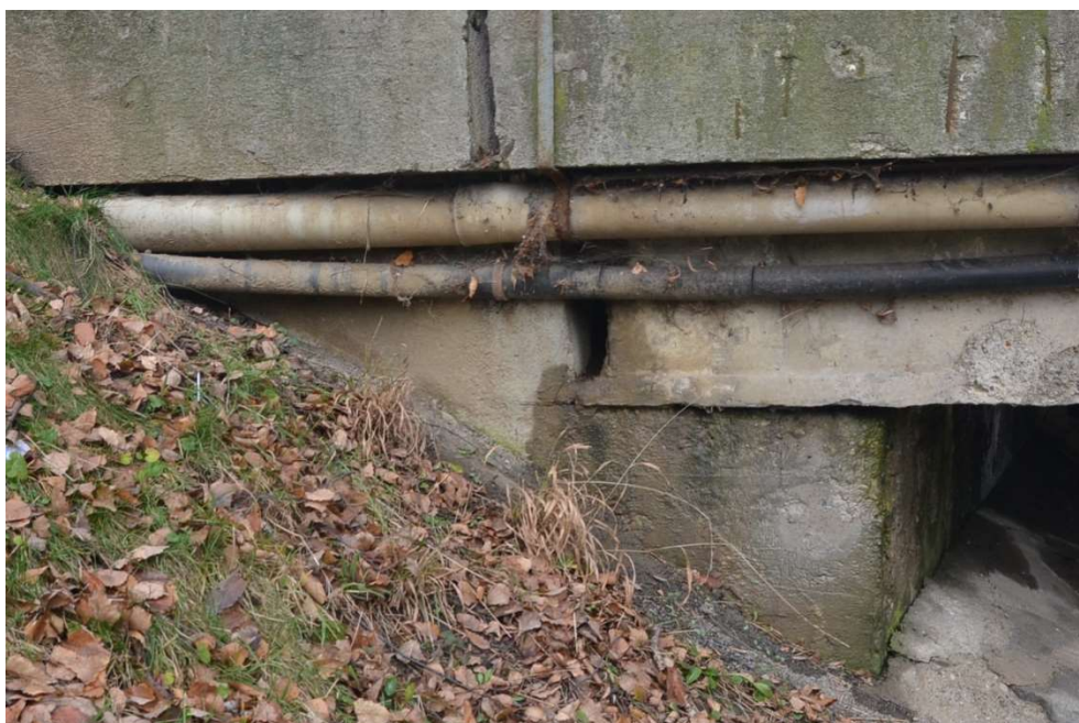
Obr.F86-10 Pravé křídlo první podpěry, levobřežní opěry. Pohled zprava doleva, po vodě,
