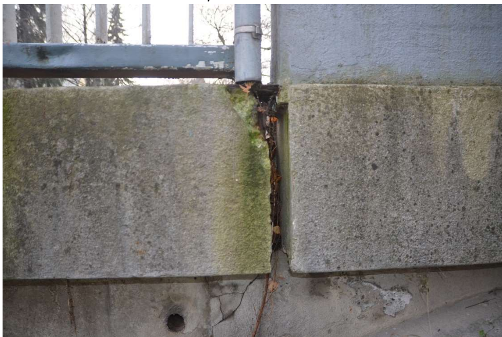
Obr.F86-27 Detail dilatační spáry v levé římse nad první podpěrrou, levobřežní opěrou. Pohled zleva doprava, proti vodě,
