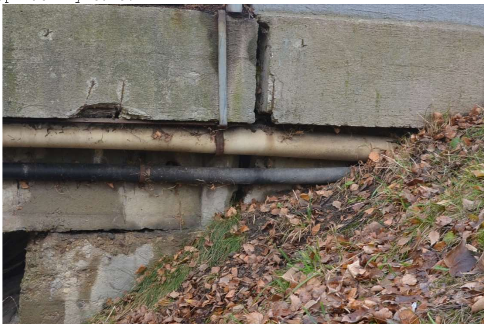
Obr.F86-12 Pravé křídlo druhé podpěry, pravobřežní opěry. Pohled zprava doleva, po vodě,
