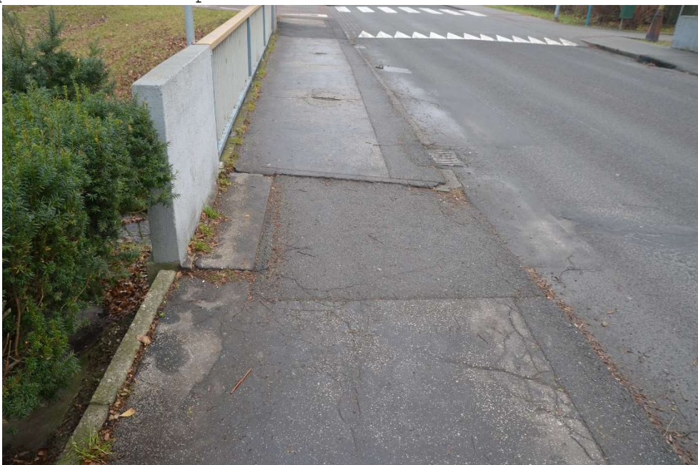
Obr.F86-28 Průhled levým chodníkem a levou částí vozovky. Pohled ve směru staničení a dolů,
