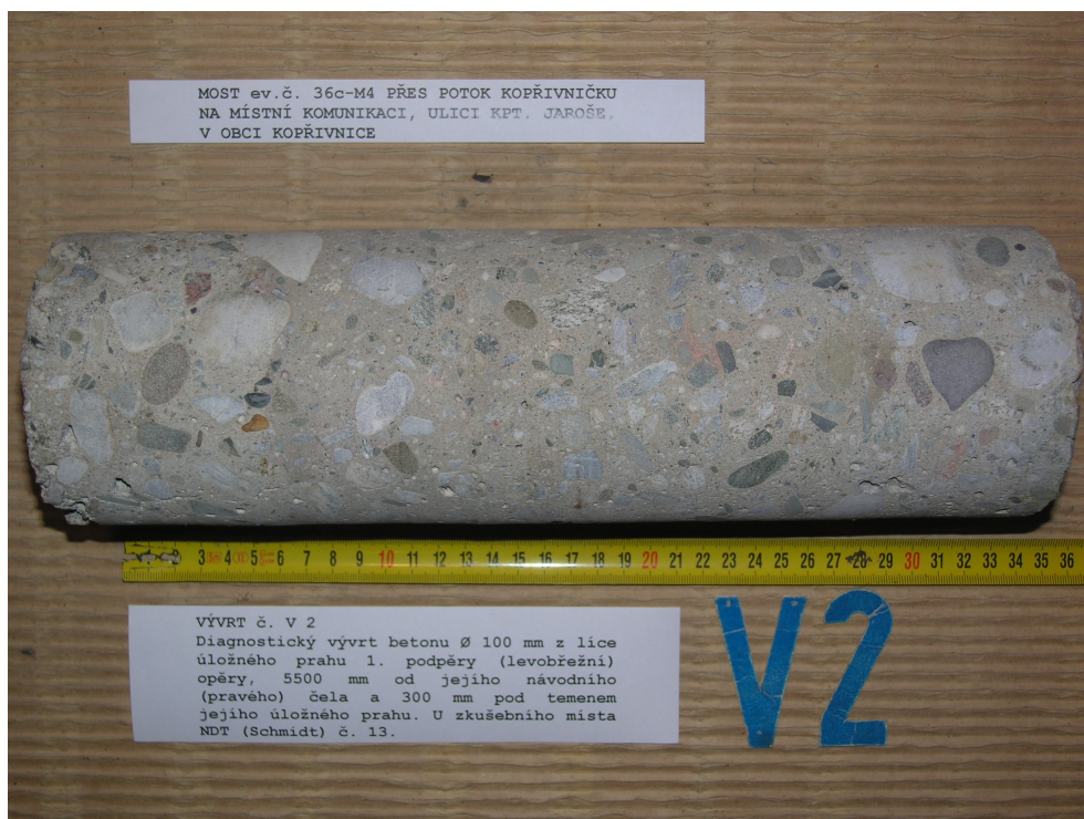
Obr. F86-301 VÝVRT č. V2. Diagnostický vývrt betonu Ø 100 mm z líce úložného prahu 1. podpěry (levobřežní) opěry, 5500 mm od jejího návodního (pravého) čela a 300 mm pod temenem jejího úložného prahu. U zkušebního místa NDT (Schmidt) č. 13.
