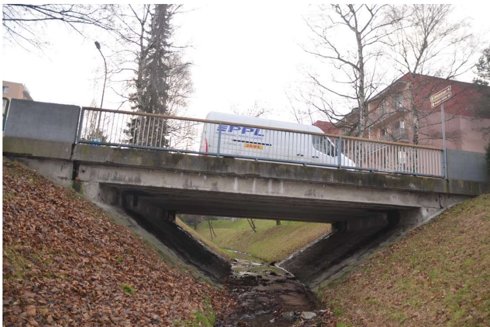
Obr.F86-03 Levá (povodní) fasáda mostu. Pohled z pravého břehu zleva doprava, proti vodě,
