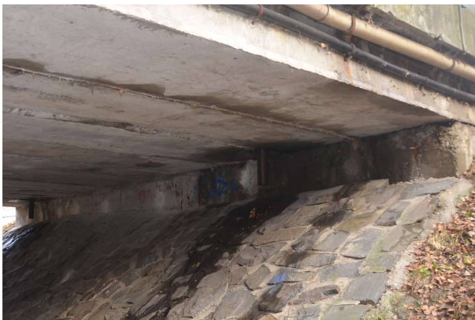
Obr.F86-08 Druhá podpěra, pravobřežní opěra. Pohled zprava doleva, po vodě a ve směru staničení,
