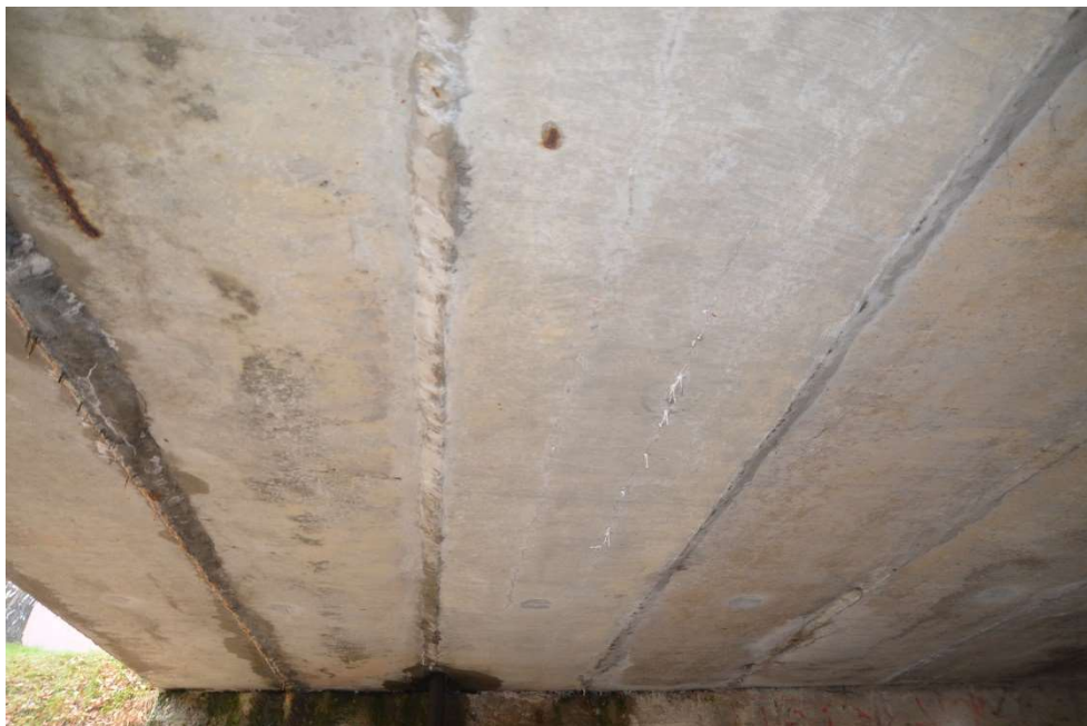
Obr.F86-23 Podhled pravé části první poloviny NK (zcela vlevo nosník č. 11). Pohled od druhé podpěry, pravobřežní opěry proti směru staničení a vzhůru,
