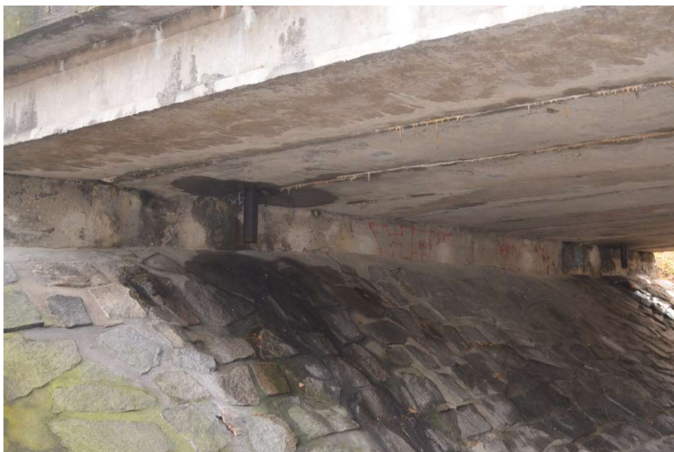
Obr.F86-07 Druhá podpěra, pravobřežní opěra. Pohled ve směru staničení a zleva doprava, proti vodě,
