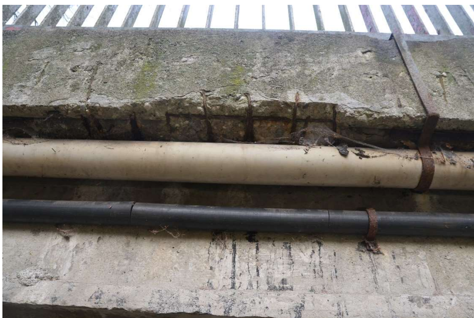
Obr.F86-18 Pravá (návodní) fasáda přibližně v 1. třetině rozpětí mostu. Pohled zprava doleva, po vodě a vzhůru,
