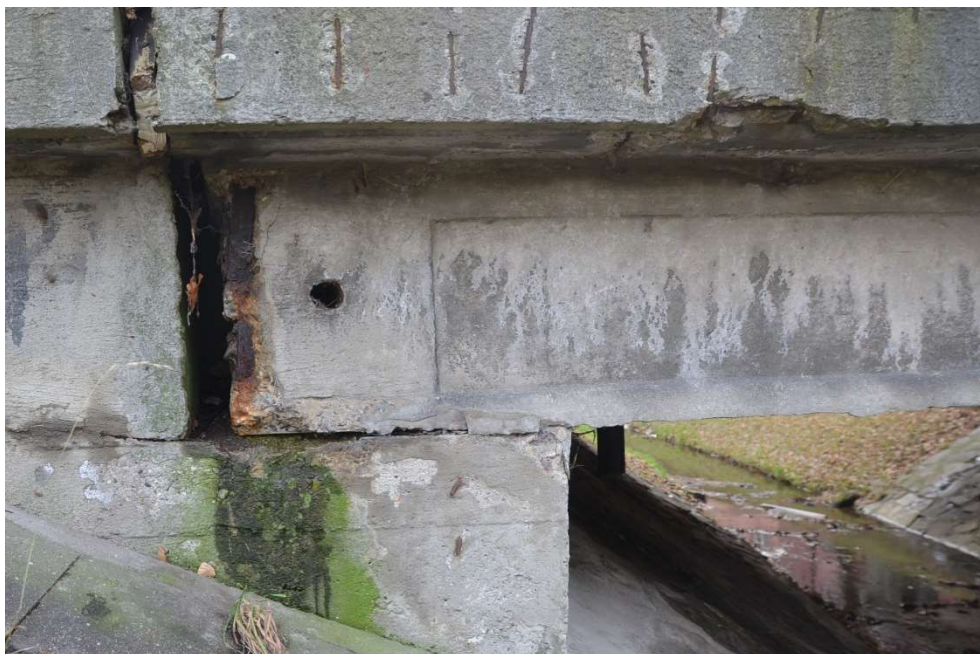
Obr.F86-16 Uložení konce nosníku č.1 na druhé podpěře, pravobřežní opěře. Pohled zleva doprava, proti vodě,
