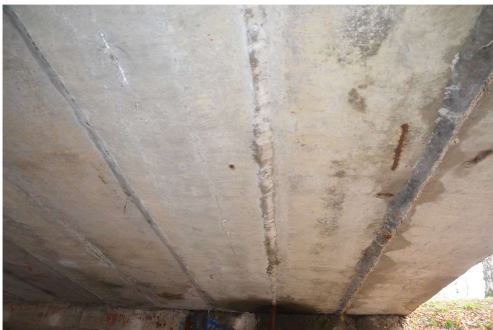
Obr.F86-26 Podhled pravé části druhé poloviny NK (zcela vpravo nosník č. 11). Pohled od první podpěry, levobřežní opěry ve směru staničení a vzhůru,
