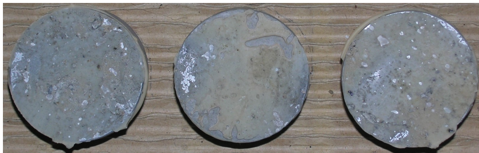
Obr.F86-204 Zkušební terče číslo 4, 127, 197 (zkušební místo 5) po provedení odtrhu.
