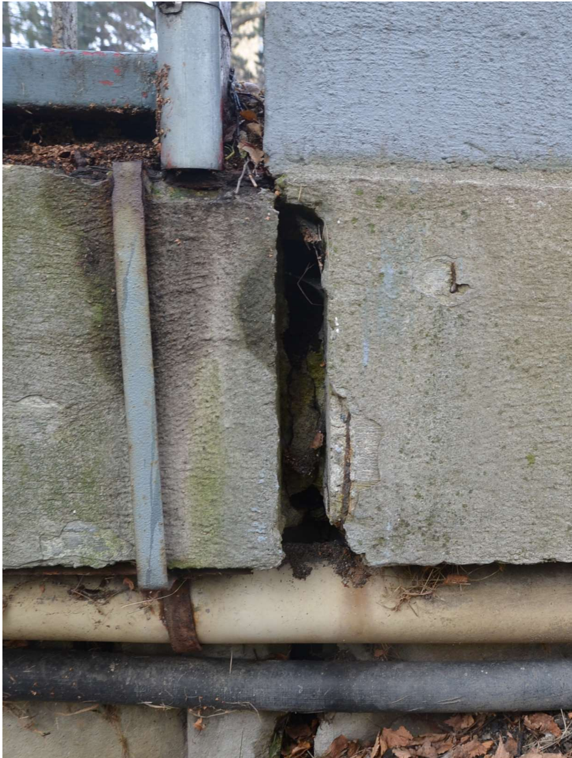
Obr.F86-37 Detail dilatační spáry v pravé římse nad druhou podpěrrou, pravobřežní opěrou. Pohled zprava doleva, po vodě,
