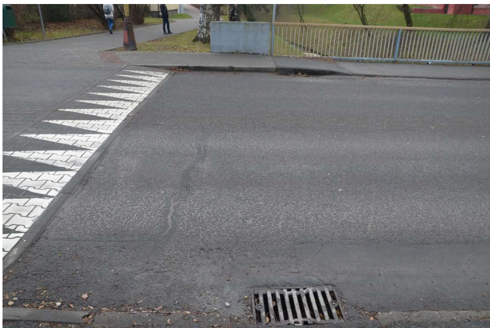
Obr.F86-35 Detail vozovky nad druhou podpěrrou, pravobřežní opěrrou. Pohled zleva doprava, proti vodě a dolů,
