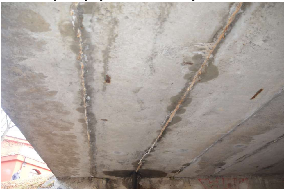
Obr.F86-24 Podhled levé části druhé poloviny NK (na obr. zcela vlevo nosník č. 1). Pohled od první podpěry, levobřežní opěry ve směru staničení a vzhůru,
