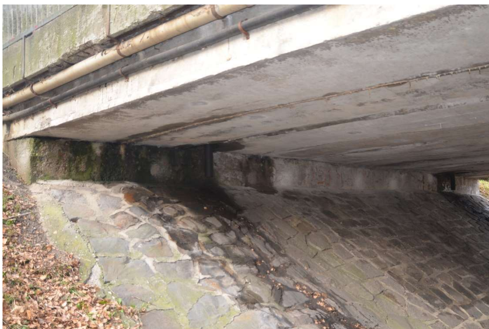
Obr.F86-06 První podpěra, levobřežní opěra. Pohled proti směru staničení a zprava doleva, po vodě,
