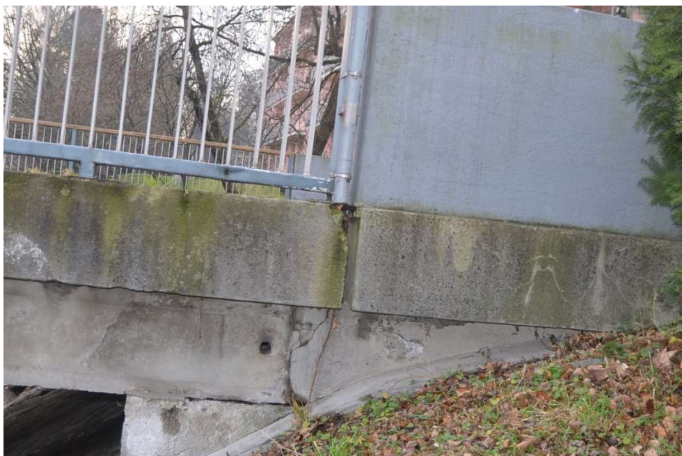
Obr.F86-09 Levé křídlo první podpěry, levobřežní opěry. Pohled zleva doprava, proti vodě,
