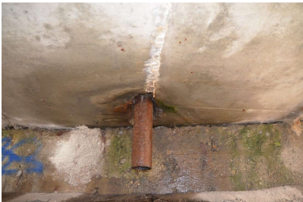
Obr.F86-40 Detail odvodňovací trubky v podélné spáře mezi nosníkem č.2 a č.3 při druhé podpěře, pravobřežní opěře. Pohled ve směru staničení a vzhůru,
