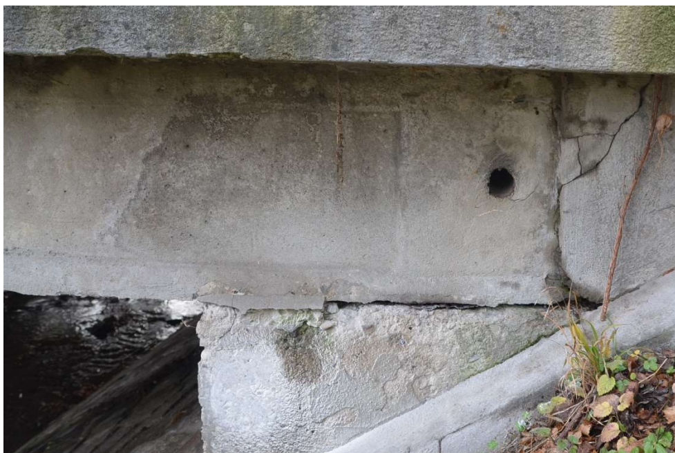
Obr.F86-13 Uložení začátku nosníku č.1 na první podpěře, levobřežní opěře. Pohled zleva doprava, proti vodě,
