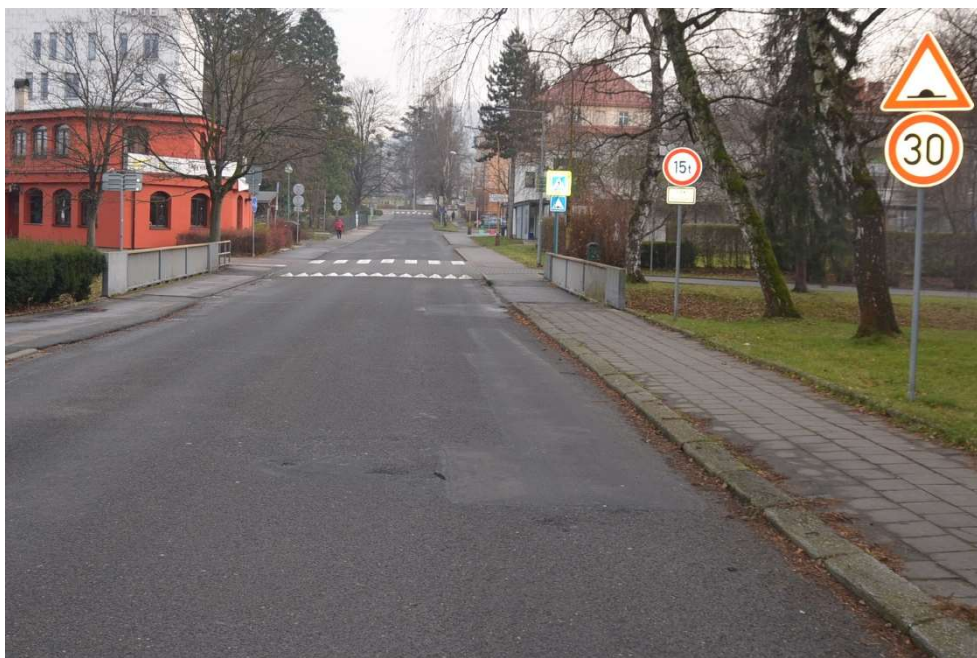
Obr.F86-01 Průhled přibližně osou mostu. Pohled ve směru staničení od ul. Záhumenní k centru Kopřivnice (k ul. Štefánikově),
