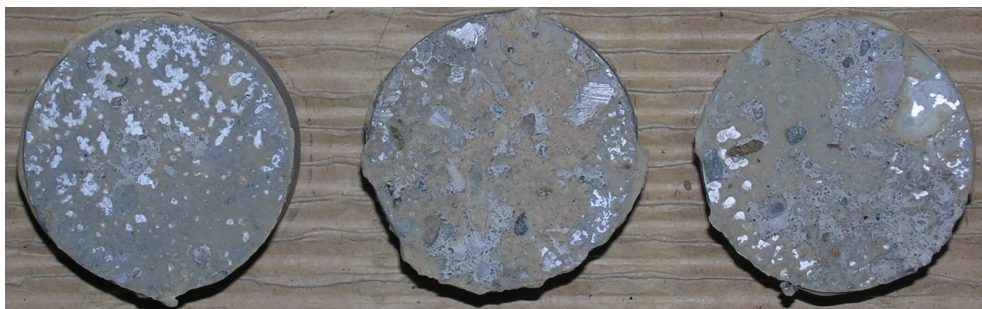
Obr.F86-200 Zkušební terče číslo -, 36, 39 (zkušební místo 1) po provedení odtrhu.
