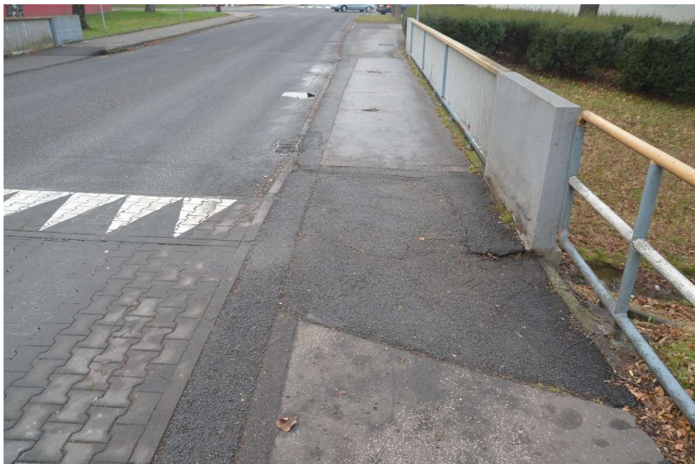
Obr.F86-33 Průhled levou částí vozovky a levým chodníkem. Pohled proti směru staničení a dolů,
