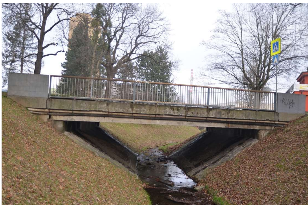
Obr.F86-04 Pravá (návodní) fasáda mostu. Pohled z levého břehu zprava doleva, po vodě,
