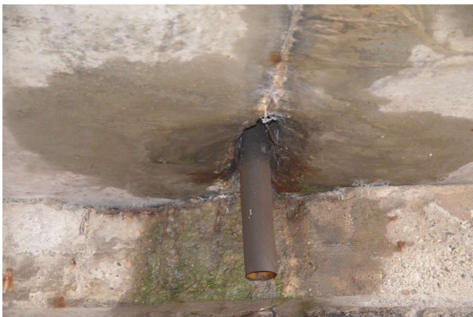
Obr.F86-41 Detail odvodňovací trubky v podélné spáře mezi nosníkem č.9 a č.10 při druhé podpěře, pravobřežní opěře. Pohled ve směru staničení a vzhůru,
