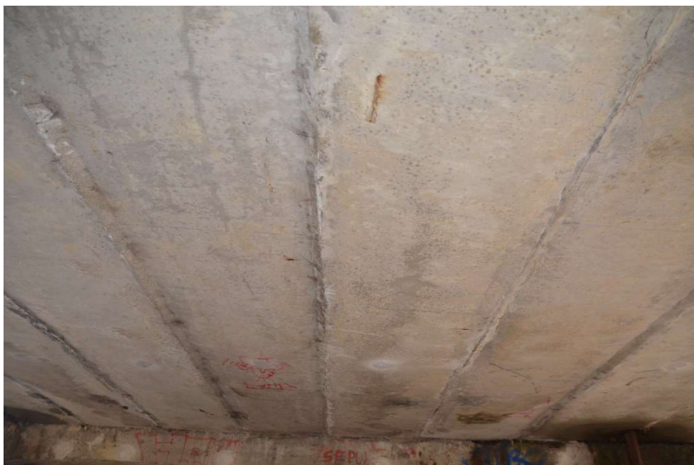
Obr.F86-25 Podhled prostřední části druhé poloviny NK. Pohled od první podpěry, levobřežní opěry ve směru staničení a vzhůru,
