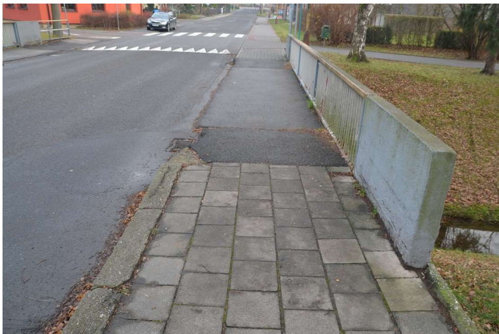
Obr.F86-30 Průhled pravou částí vozovky a pravým chodníkem. Pohled ve směru staničení a dolů,
