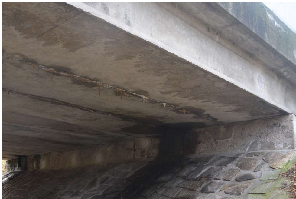
Obr.F86-05 První podpěra, levobřežní opěra. Pohled zleva doprava, proti vodě a proti směru staničení,
