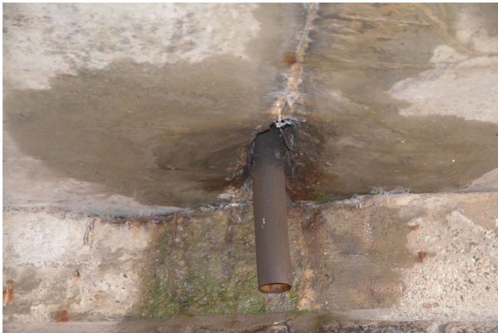
Obr.F86-38 Detail odvodňovací trouby v podélné spáře mezi nosníkem č.2 a č.3 při první podpěře, levobřežní opěře. Pohled proti směru staničení a vzhůru,
