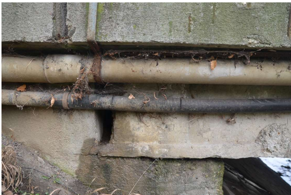
Obr.F86-17 Uložení začátku nosníku č.11 na první podpěře, levobřežní opěře. Pohled zprava doleva, po vodě,
