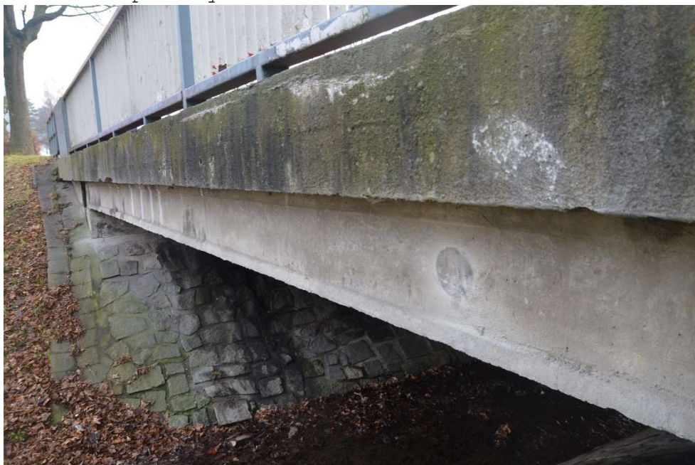
Obr.F86-14 Levá (povodní) fasáda mostu. Pohled od první podpěry, levobřežní opěry ve směru staničení a zleva doprava, proti vodě,
