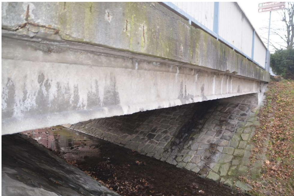
Obr.F86-15 Levá (povodní) fasáda mostu. Pohled od druhé podpěry, pravobřežní opěry zleva doprava, proti vodě a proti směru staničení,
