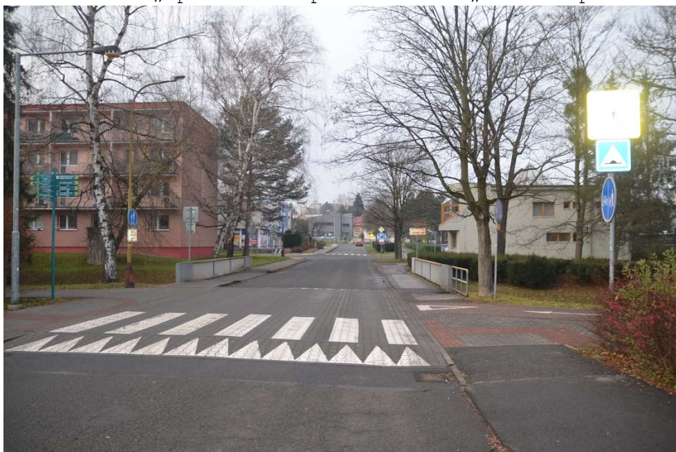
Obr.F86-02 Průhled přibližně osou mostu. Pohled proti směru staničení od centra Kopřivnice (ul. Štefánikovy) k ul. Záhumenní,
