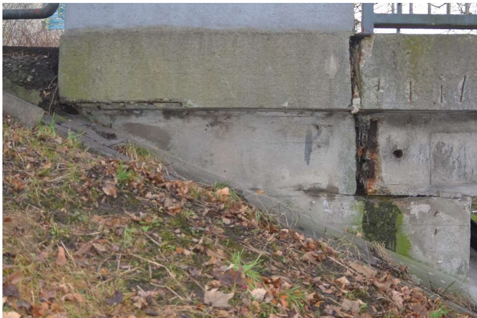
Obr.F86-11 Levé křídlo druhé podpěry, pravobřežní opěry. Pohled zleva doprava, proti vodě,
