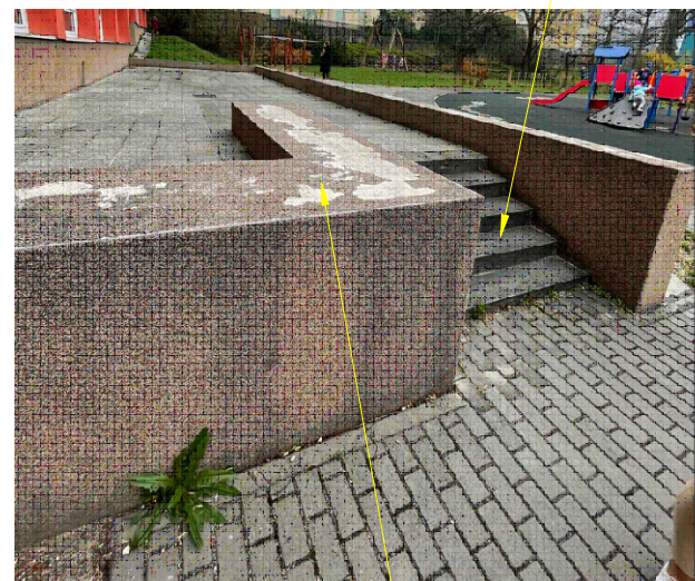
očistění stávající soklové omítky z marmolitu, případně oklepání odstávajících částí
