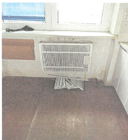
Stávající plynové topidlo 6140 – kuchyň
