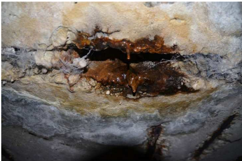
Obr.F87-24 Detail podélné spáry u příčle č.20. Pohled zleva doprava, ve směru staničení a vzhůru,
