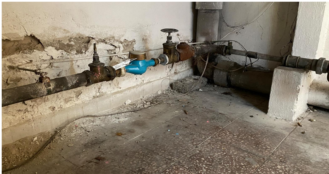
Obr. 9 – Stávající vodoměrná sestava v prostorách suterénu pod hlavním schodištěm
