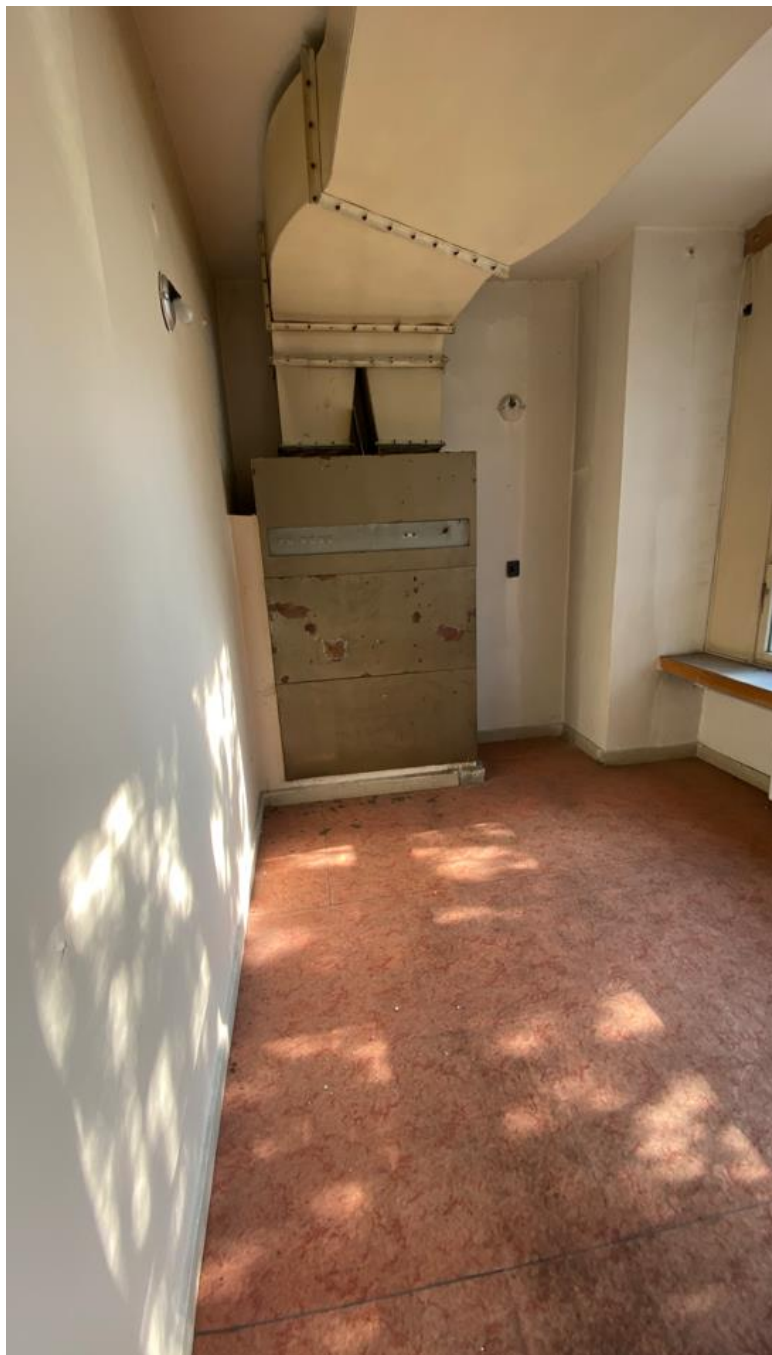
Obr. 8 – Původní VZT jednotka pro odvětrávání stávající varny
