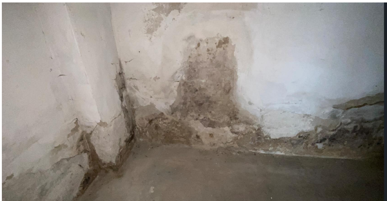
Obr. 10 – Vlhkost zdiva v prostorách 1S
