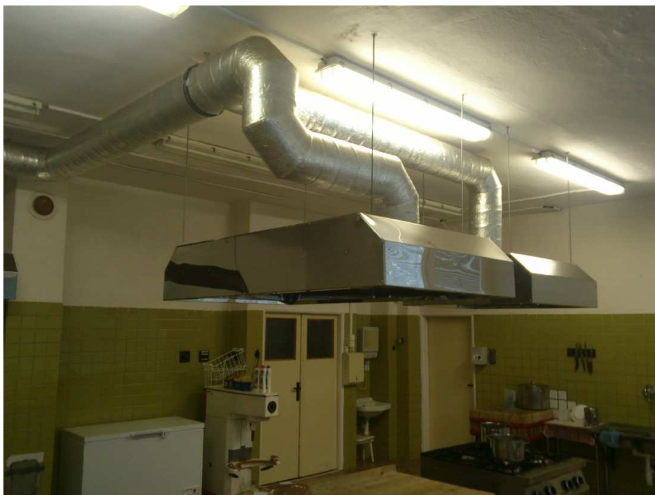
Obr. 3: Nucený odtah v kuchyni (varně)
