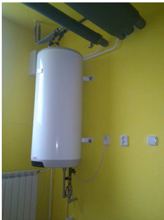
Obr. 5: OT na mezipodestě do suterénu; zásobníkový ohřívač, a otopné těleso, v šatně v suterénu
