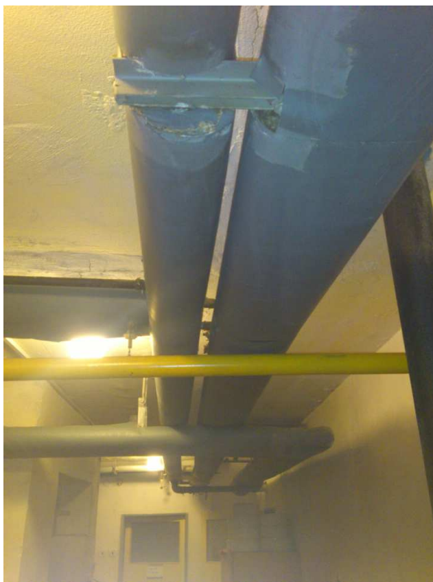
Obr. 8: Rozvody tepla v chodbě, v suterénu
