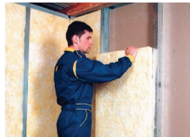
ILUSTRACNÍ FOTO AKUSTICKÉ MINERÁLNÍ IZOLACE SE SKELNÝCH VLÁKEN VKLÁDANÉ MEZI OCEL PROFILY (ROZTEC 600-625 MM) POKLÁDANÉ VERTIKÁLNĚ NA CELOU VÝŠKU STĚNY
