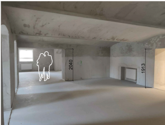
STÁVAJÍCÍ STAV - MÍSTNOST S BAREM
