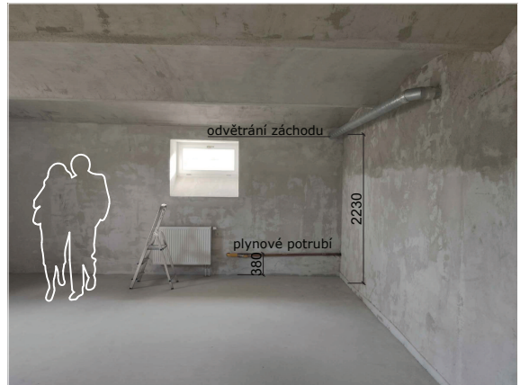
STÁVAJÍCÍ STAV - PROSTOR RESTAURACE III.
