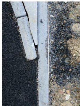
Správně provedený dořez Chybně provedené napojení Správné použití bet.obrub.nařezaných délek cca 250mm
