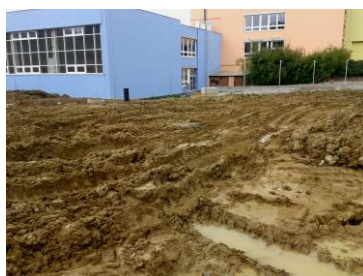
Vyobrazení příkladů znehodnocení zemní pláně traktorbagrem v deštivém období
