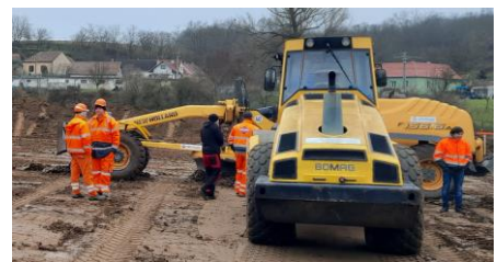
Případně možno použít vhodnou těžší techniku s vhodnými pneumatikami a velkými poloměry otáčení
