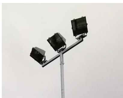
Chybně nasměrovaná asymetrická svítidla
