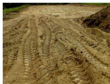
Vyobrazení příkladů znehodnocení zemní pláně traktorbagrem v deštivém období
