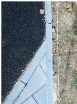
Správně provedený dořez Chybně provedené napojení Správné použití bet.obrub.nařezaných délek cca 250mm
